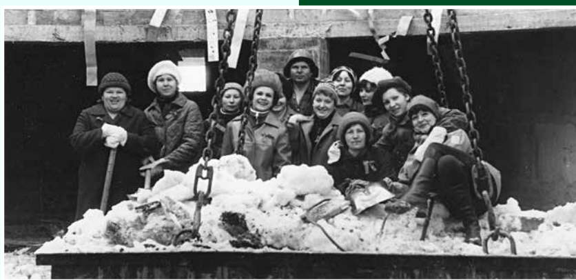
На строительстве Дворца, конец 80-х
